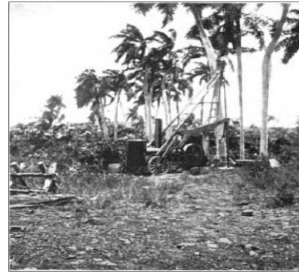
Equipo de perforación a vapor en el campo Bacuranao en 1901.
